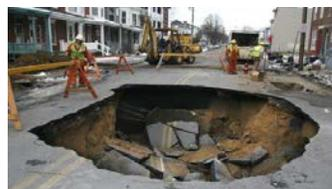
Figura 11: Cratera por vazamento de água em Harrisburg- Pensilvânia. / Fonte: Lancasteonline
