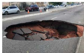
Figura 12- Cratera causada por vazamento de água, em João pessoa-Paraíba. / Fonte: G1(2018)
